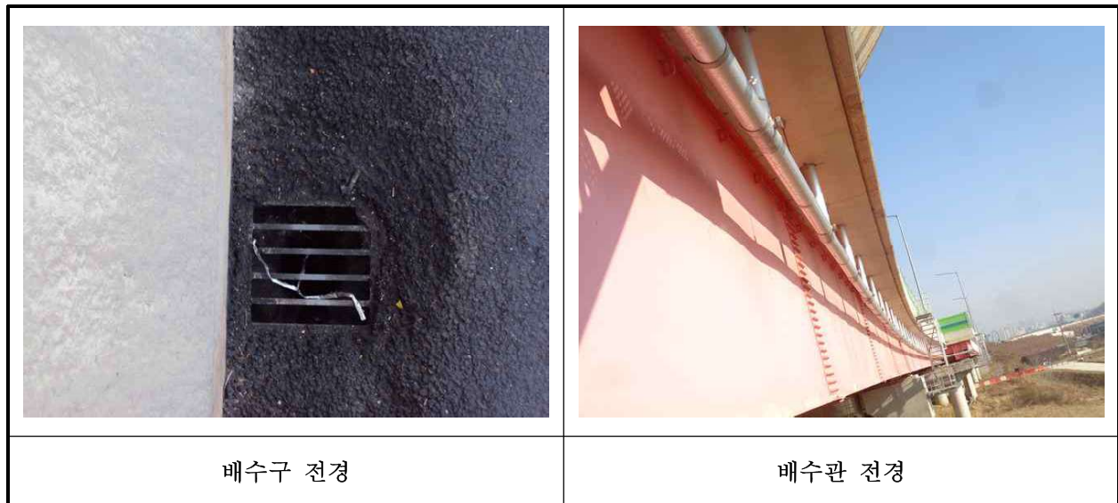
【사진 1.3.21】 배수시설 전경
