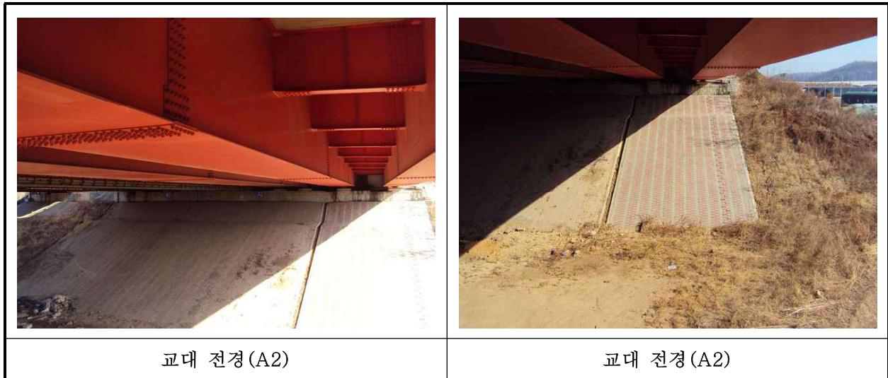
【사진 1.3.8】 교대 전경
