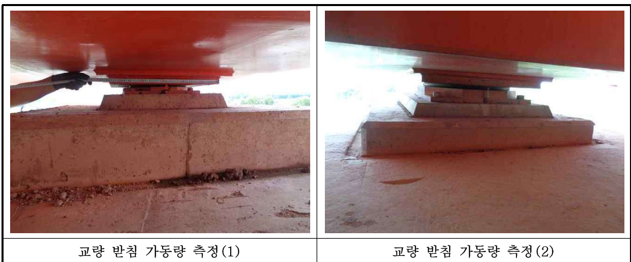
【사진 1.3.15】 교량받침 이동량 측정
