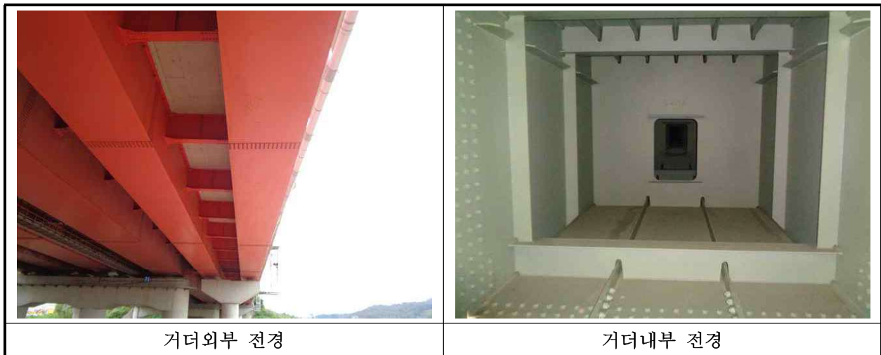
【사진 1.3.4】 거더 전경
