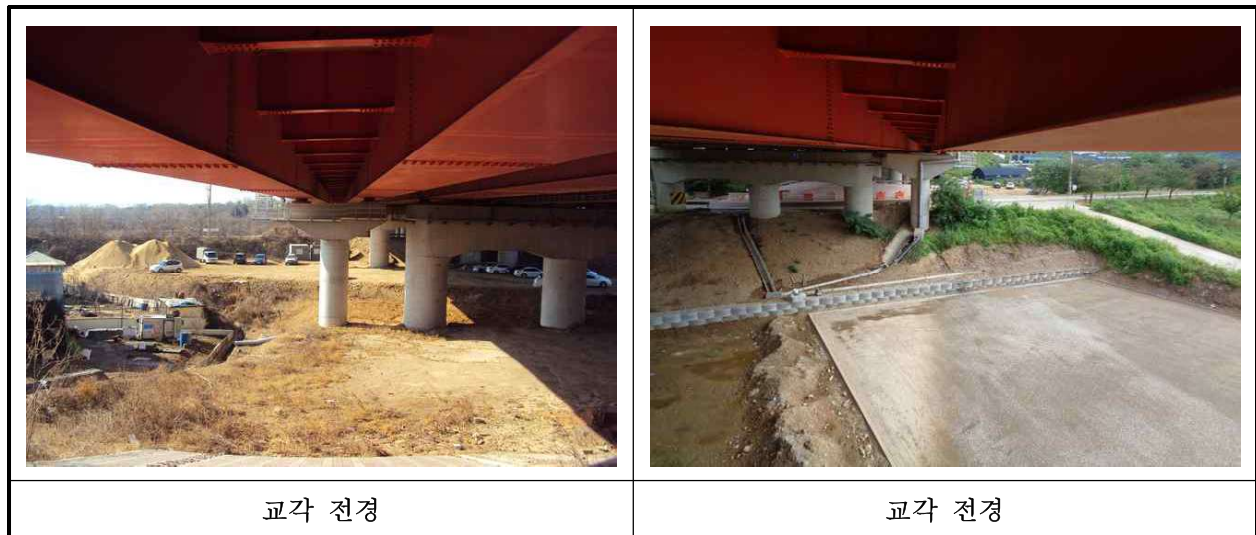
【사진 1.3.10】 교각 전경
