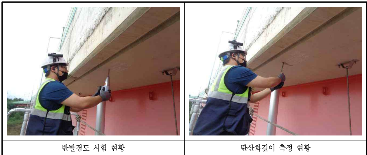
【사진 1.4.1】 콘크리트 내구성조사 현황
