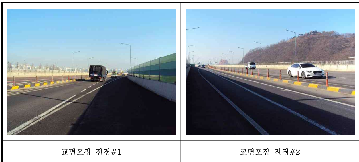
【사진 1.3.19】 교면포장 전경
