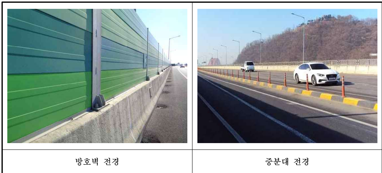
【사진 1.3.23】 방호벽 및 중앙분리대 전경
