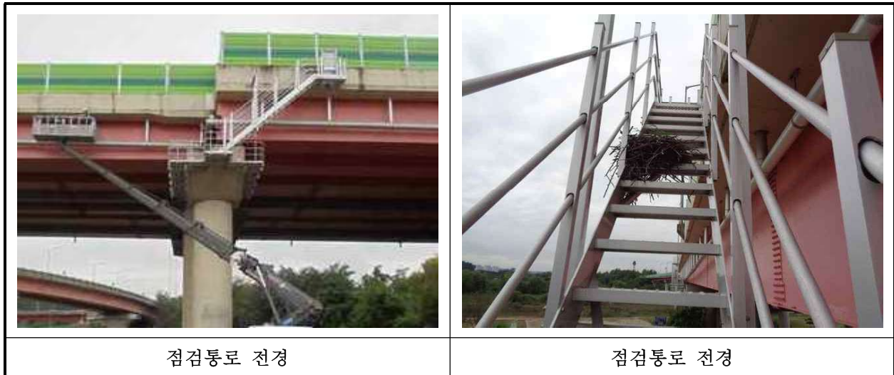
【사진 1.3.25】 교량 점검시설 전경
